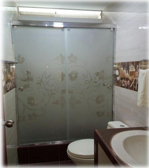
Vidrio templado de 6mm arenado con diseño y kit de aluminio brillante.
