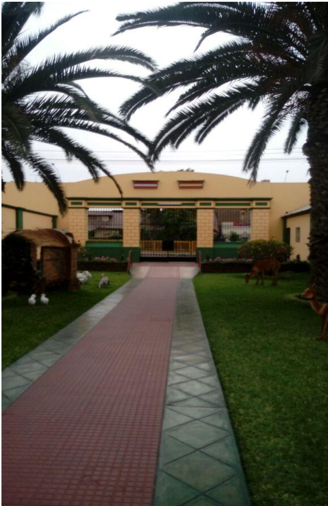
Foto13. Portón principal de la congregación de hermanitas de los ancianos desamparados
