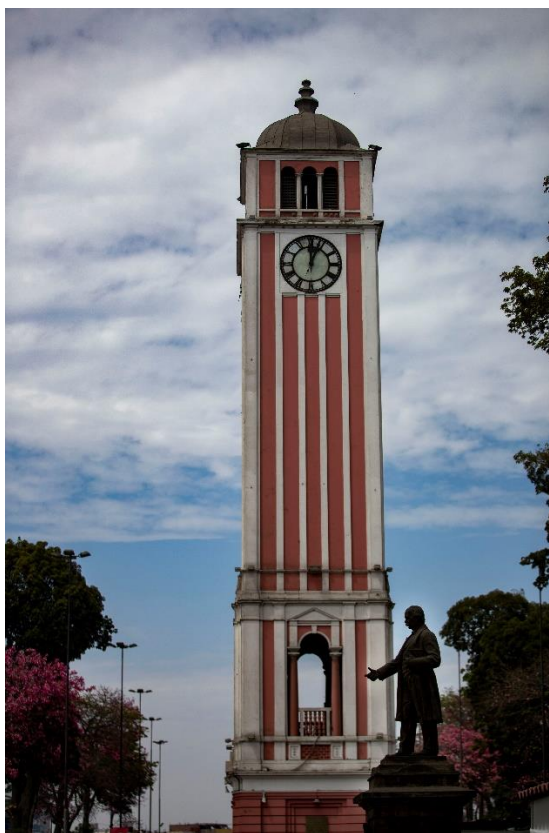
Figura 4. Torre reloj donada por la colonia alemana. Fuente: Municipalidad de Lima
