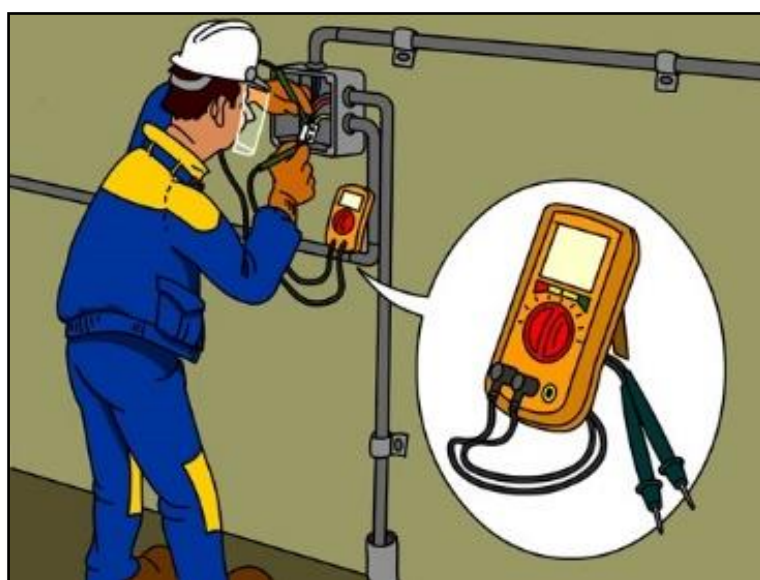
Figura 8 Verificación de tensión eléctrica
