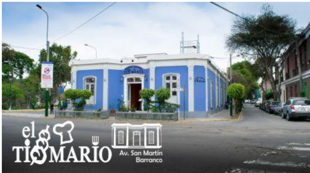
Figura N° 2 Fachada principal Anticucheria Tio Mario SAC, San Martín.
