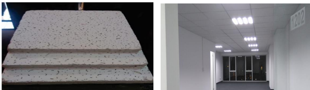
Figura 10: Cielo raso en fibra de vidrio
