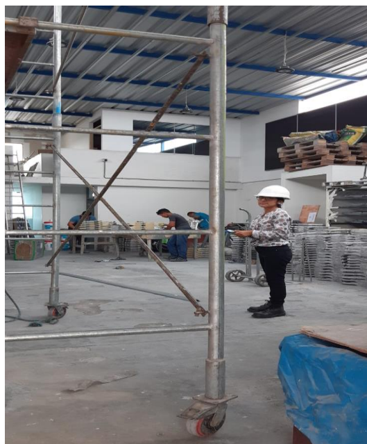
Figura 22: Inspección in situ Fuente: Elaboración propia
