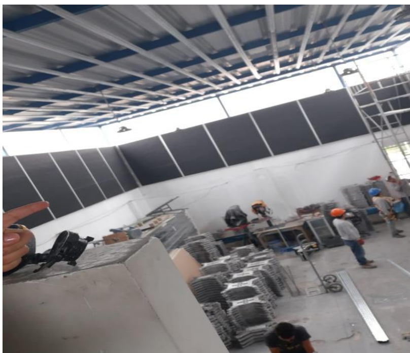
Figura 18: Colaboradores de obra esperando materiales Fuente: Elaboración propia
